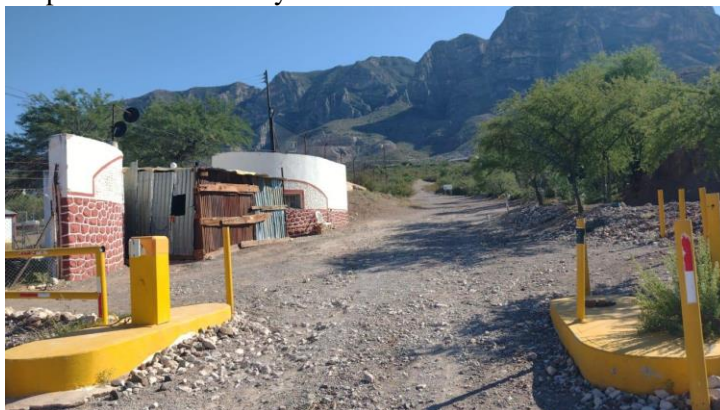
Imagen 4: Acceso principal del sitio del Proyecto a diciembre de 2024.
